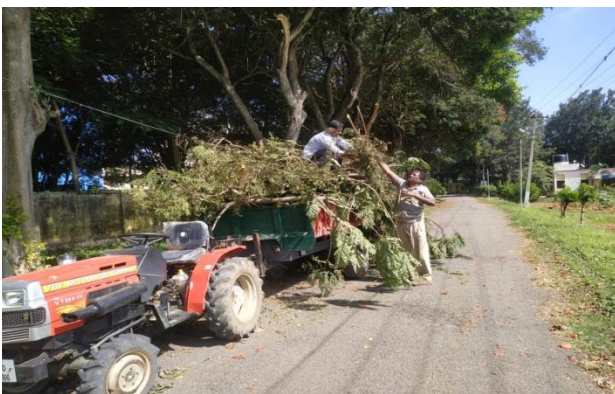
मार्ग में आनेवाले पेड़ों की छंटाई Trimming of Avenue trees
