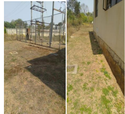
विद्युत कक्ष के आसपास के क्षेत्रों की सफाई Cleaning of surrounding areas of Electrical room
